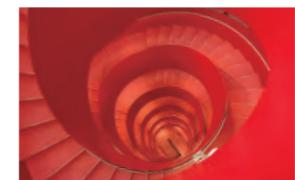
各階フロアをつなぐ螺旋階段は、自然換気システムから取り入れた外気の通り道にも
