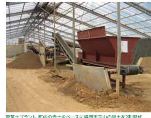
育苗土プラント。町内の赤土をベースに盛岡市玉山の黒土を2割混ぜ、それをバーナーで消毒し8ミリ網でふるう
