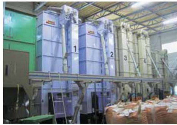
乾燥機やもみすり機(ヤンマーACH60)などがズラリと並ぶミニライスセンター内部
