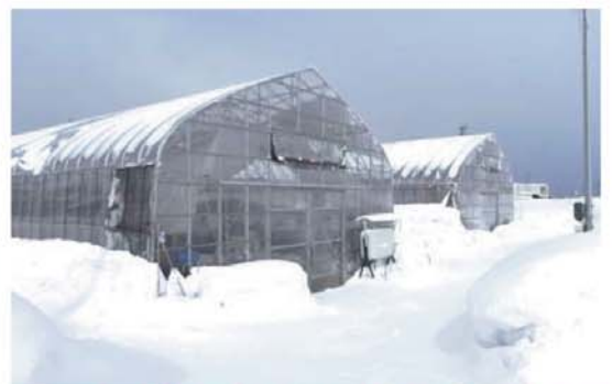
こだわりのトマトと冬野菜を栽培する大型ハウス。幅10m、奥行き80m、高さ6mと、高く大きいだけでなく、パイプが太くて12mごとに補強パイプが入っている。屋根の角度なども雪が滑りやすい設計で、今年2月の積雪1.3mにもびくともしない
