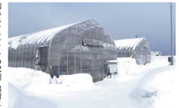
こだわりのトマトと冬野菜を栽培する大型ハウス。幅10m、奥行き80m、高さ6mと、高く大きいだけでなく、パイプが太くて12mごとに補強パイプが入っている。屋根の角度なども雪が滑りやすい設計で、今年2月の積雪1.3mにもびくともしない
