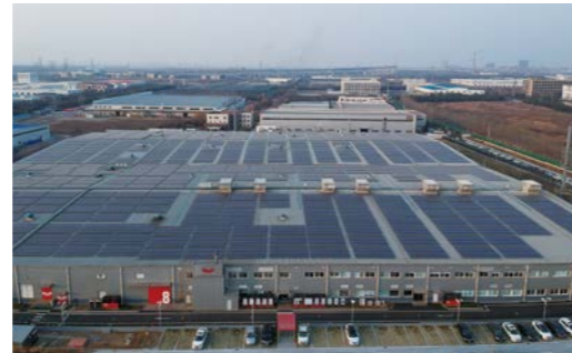
屋根に設置した太陽光発電システム
