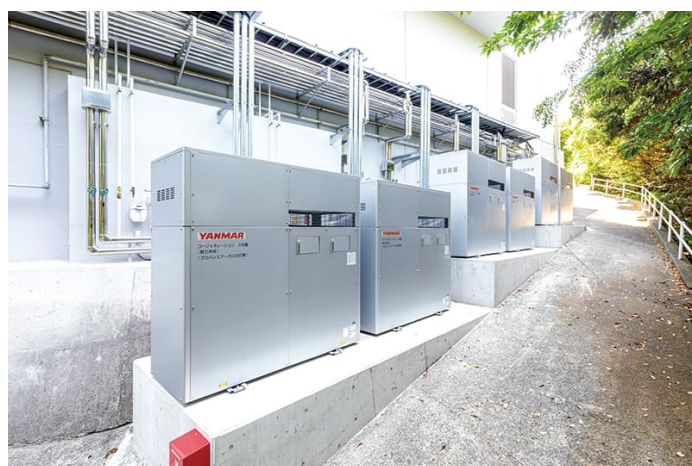
ホテルアンピア松風閣に設置したコージェネレーションシステム
