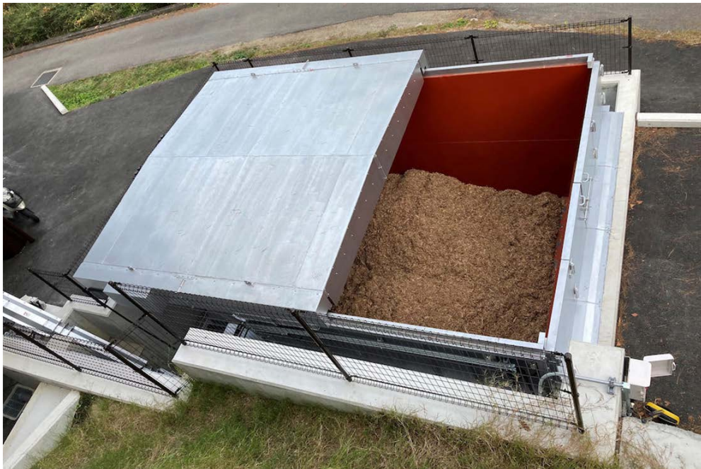
ボイラー燃料庫
