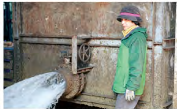
(上)搾乳牛舎とホスピタル牛舎に完備されたフラッシュシステム。一気に流れる大量の水によって床をくまなく洗浄する。(左)糞尿を急速発酵処理するコンポストを3基備えている。1日に15トンの糞尿を処理できる。
