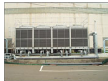
▲試運転冷却水用クーリングタワーの更新
