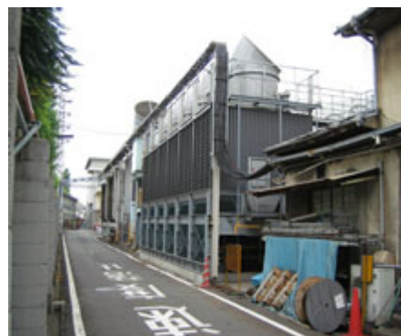
▲尼崎工場の冷却水ピット冷却クーリングタワー 今までは、冷却水ピットの温度を30℃以下に保つために工業用水を投入していましたが、クーリングタワーによる冷却で、工業用水の投入を大幅に低減しました。
