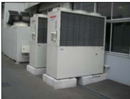
▲ GHP 室外機の設置状況 20PS×2 台
