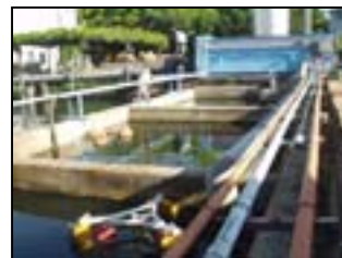
▲ 排水経路の油水分離槽
