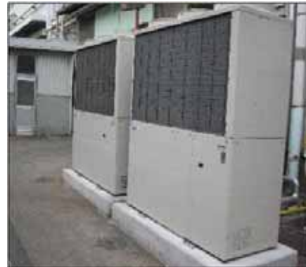
第7工場のGHP室外機設置状況 20PS×3台 もう一基は見えない所に設置されている
