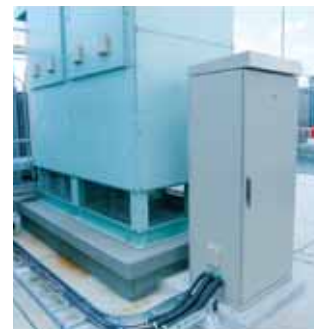
電力回生装置（尼崎工場）
