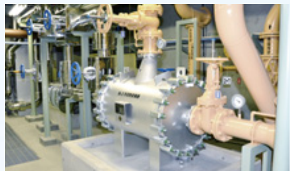
コージェネからの温水を熱交換する污泥熱交換器
