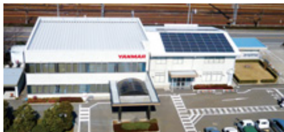
尼崎工場別館屋根に取り付けられた太陽光パネル
