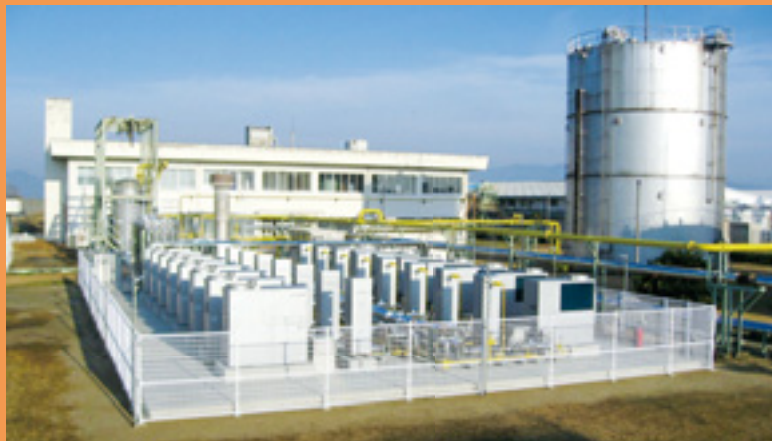
バイオガスマicroコージェネレーションシステム16台設置
