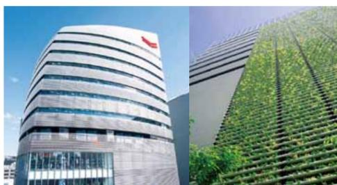
ヤンマー本社ビルは、最新の技術で幅24m、高さ52mの大型壁面緑化を実現。室内空間の快適化を進めるとともに、養蜂活動により都市生態系の創出を追求。さらにはCO2排出量ゼロを掲げ、最新のエネルギー変換技術による省エネを進めるなど、環境と共生する新時代のビルのあり方を体現します。
