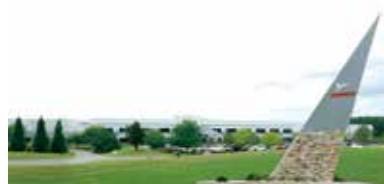
YAのアトランタ第2工場
