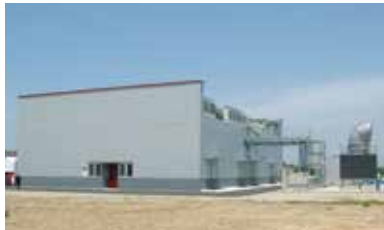
びわ工場エミッション棟
