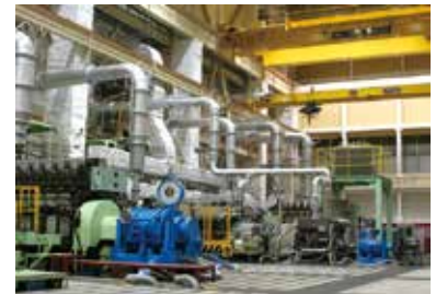
尼崎工場の大形試験棟竣工(2007.12)
