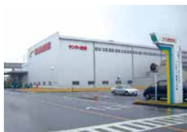
ヤンマー建機に新塗装工場が完成(2006.10)
