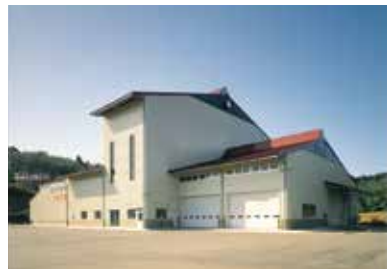
DAG (Dry Air Generator)全量貯留施設1号機
