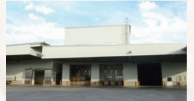
2013年に完成したたまねぎ乾燥施設は、床面積1,360㎡、616室のラックで個別の乾燥・管理が可能。4,000tの収量にも対応できる(写真上)。乾燥室内で24~36時間かけて水分を5%下げる(写真左)。
