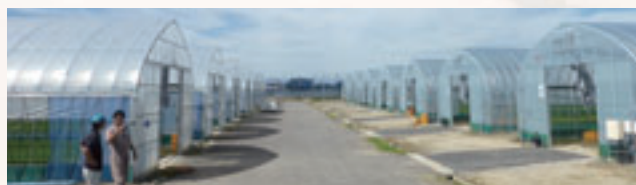
全15棟の育苗施設で、2016年は14,000枚を生産。後利用を考え、フォークリフトが入れるように地面を整備している。
