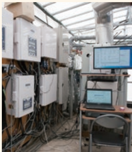
ハウスには制御室が隣接し、ハウス内環境を自動制御。ハウス内環境も各種設備の稼働状況もリアルタイムで確認できる。左が各棟の制御装置。
