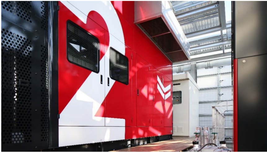
ヤンマー本社ビルに導入したガスコージェネレーション (400kW)
