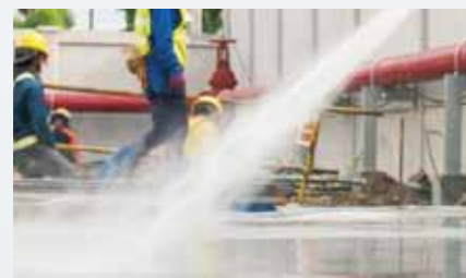
土木建築現場に
