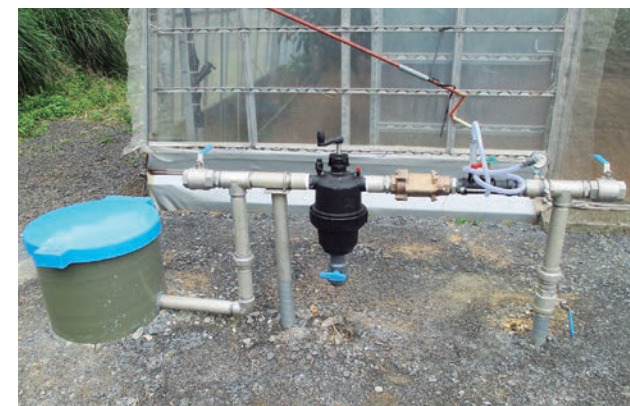
給水口(フィルター・減圧弁・混入器)
