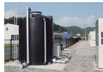
ハウスタンク設置
