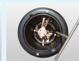
インターナル取り外し状況
