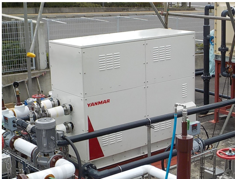
<今回設置したオーガニックランキンサイクル式発電機>
