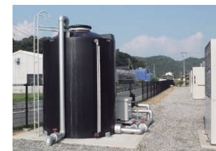
ハウスタンク設置
