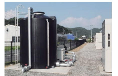
ハウスタンク設置
