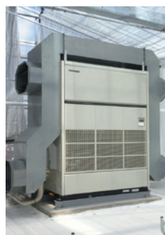
ポリダクト設置
