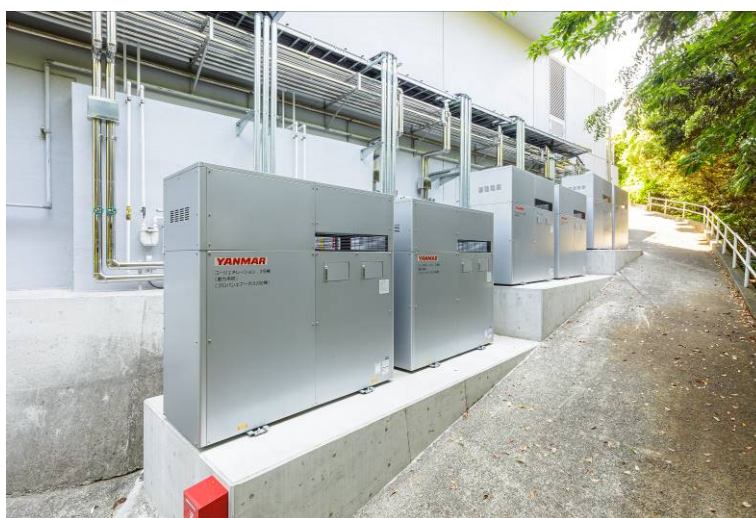
＜ホテルアンビア松風閣に設置したコージェネレーションシステム＞
