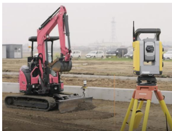
<3D マシンコントロールによる作業現場イメージ>
