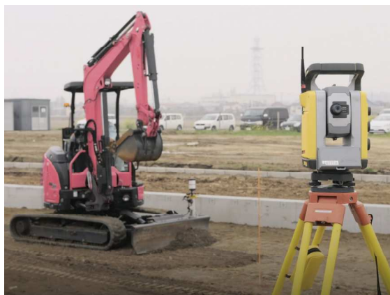
<3D マシンコントロールによる作業現場イメージ>
