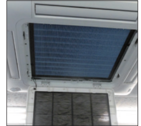
抗菌加工高性能フィルターをてんかせ4方向に取り付けた写真
