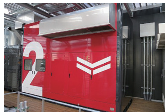
ガスコージェネレーションシステム(EPGシリーズ) (FLYING-Y BUILDINGのみの特別塗装)
