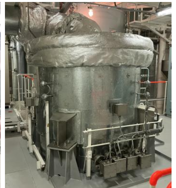
【船内のメタンスリップ削減システム (左：EGR※ 2 システム、右：メタン酸化触媒層)】
